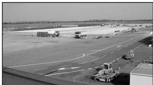
Ruspe al lavoro in aeroporto per il nuovo Cargo Building.
